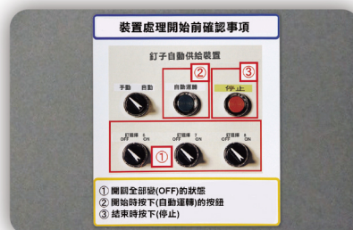
設備操作標識
